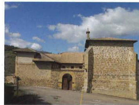
(Foto: Entrada Convento San Juan de Acre. Autor: Juan Carlos Abascal)
